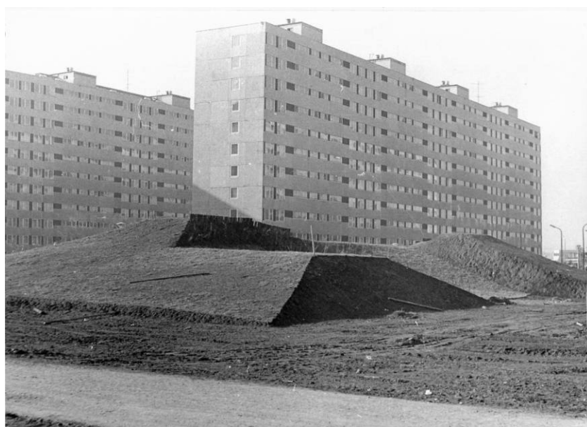
90. ábra - Budapest XIV. kerület, Zuglói lakótelep, rólldombok kivitelezés közben
