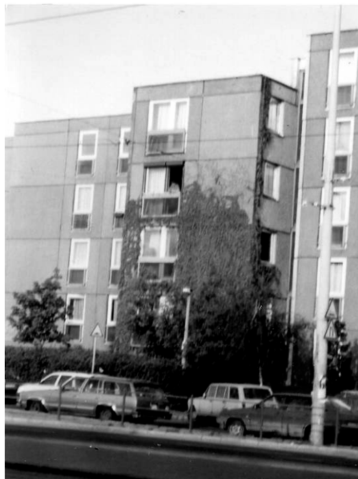
102. ábra - Panelház befuttatott fala
