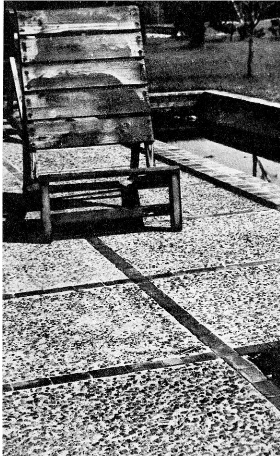
48. ábra - Betonburkolat klinkertégla raszterrel
