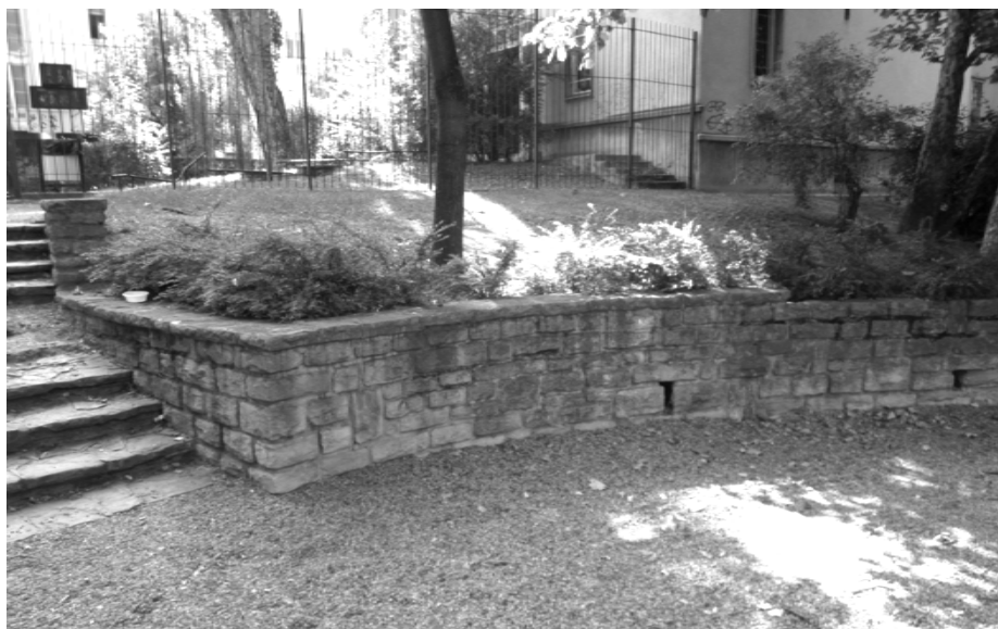
28. ábra - Kőburkolat a Budapest XI. kerület, Lágymányosi úti lakótelep tömbbelsőben
