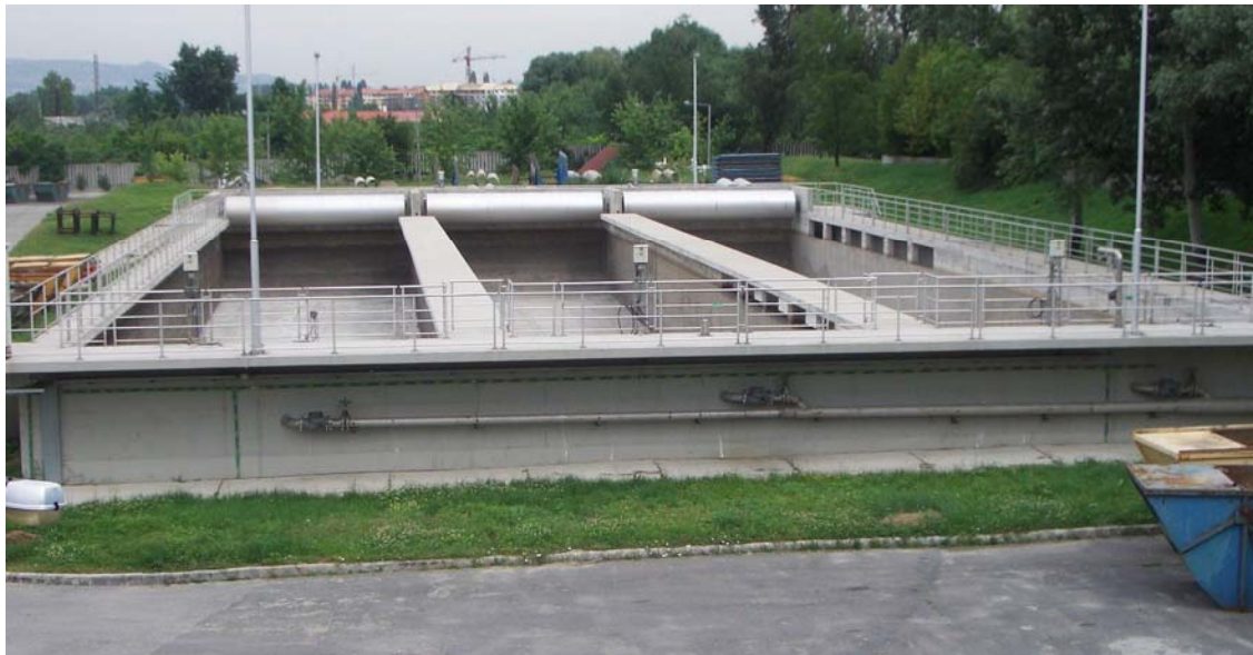
3.39 ábra. A Dél-Pesti Szennyvíztelep záportározója
