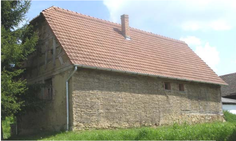
40. További példa a fachwerk technikára Zsibriken
