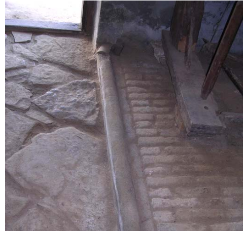
281. A lakóháznál is nagyobb gondot fordítottak az istállóra, ahol szilárd téglaburkolat volt. A trágyalé a betonszegély mentén folyt be a trágyalé-gödörbe
