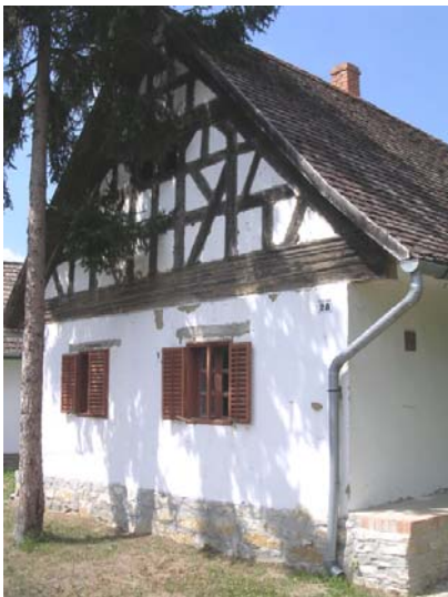
39. Fachwerk technikával épített és helyreállított, a hazai építészet-történetben kuriózumnak számító ház első és hátsó homlokzata Zsibriken
