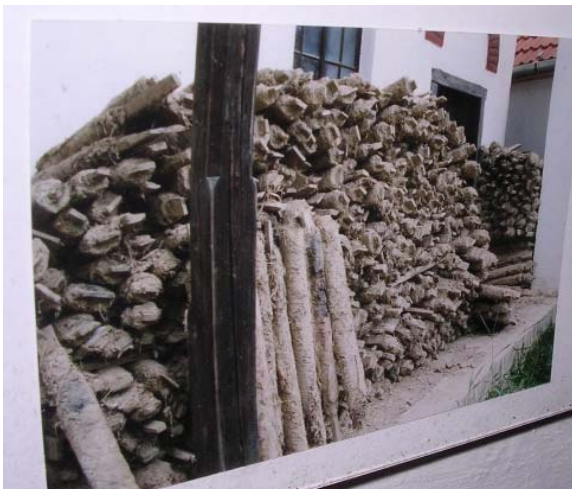
42. A födémgerendák között béléstest helyett az ún. „Wicklholz”-cal töltötték ki
