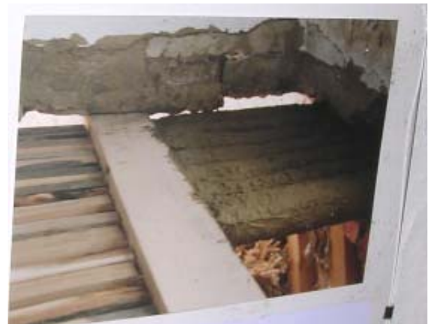
42. A födémgerendák között béléstest helyett az ún. „Wicklholz”-cal töltötték ki
