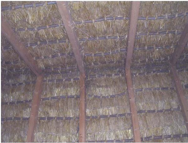
43. A tetőfedés hagyományos anyaga a hosszúszalú rozs-, más néven zsúpszalma volt. A Délkelet-Völgységben ma egyetlen épületen, az ófalui tájházon látható zsúptető.
