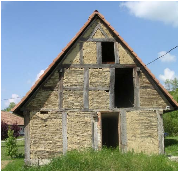
41. A 40. ábrán bemutatott ház hátsó homlokzatán a favázat patics technikával töltötték ki
