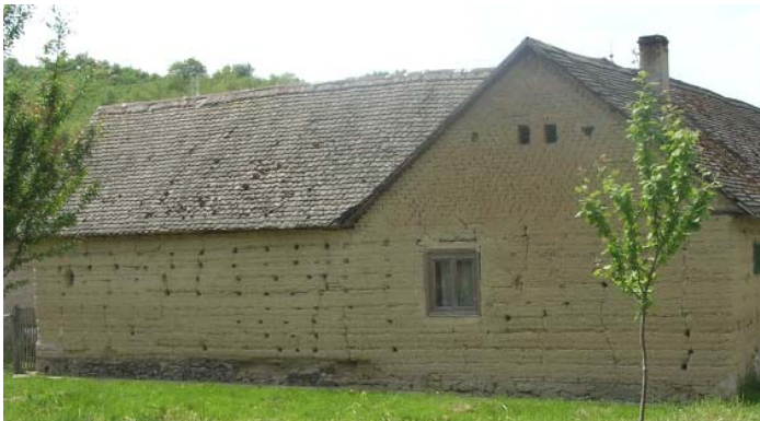
44. A falépítési technika egyik lehetséges módja a döngölés. A rétegenként ismétlődő lyukak a tapasztás alatt, a döngölt fal zsaluzatának nyomai.
