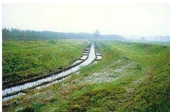
4. fotó. A Galga-patak középső szakasza (átalakított szántóföldi patak)
